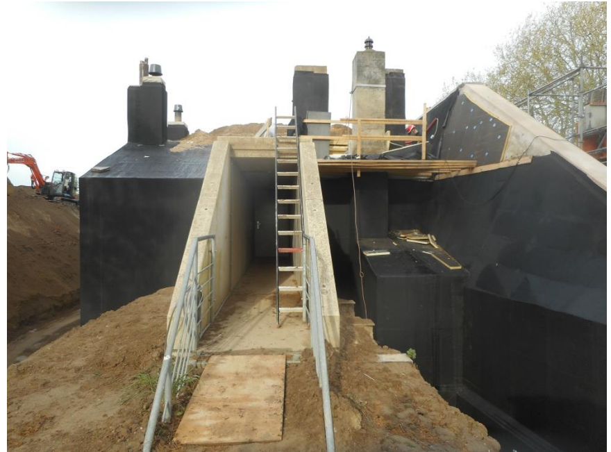
Isolatie (gecombineerd met dakbedekking)
