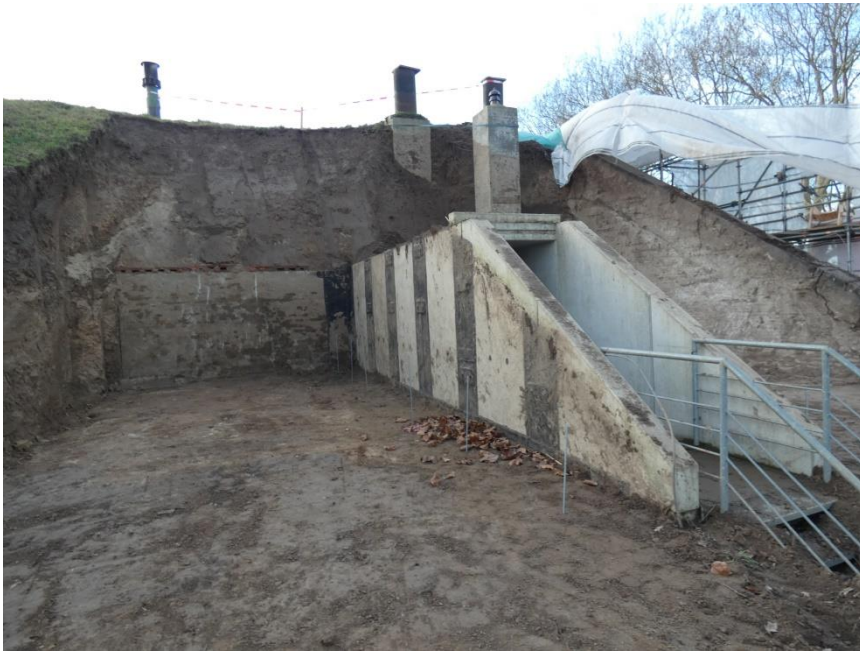
Voor aanbrengen isolatie
