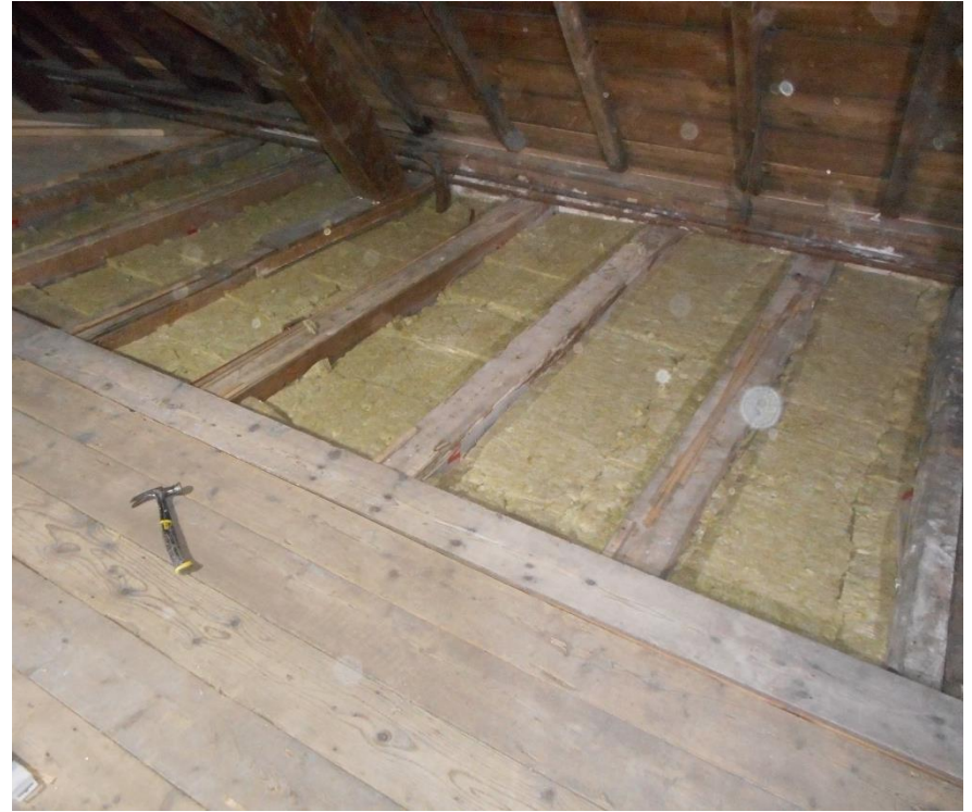
Met isolatie (koud dak systeem)
