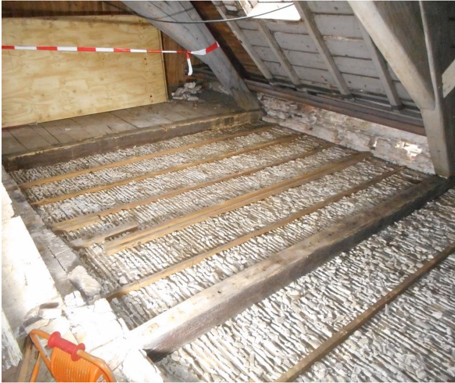
Zoldervloer zonder isolatie
